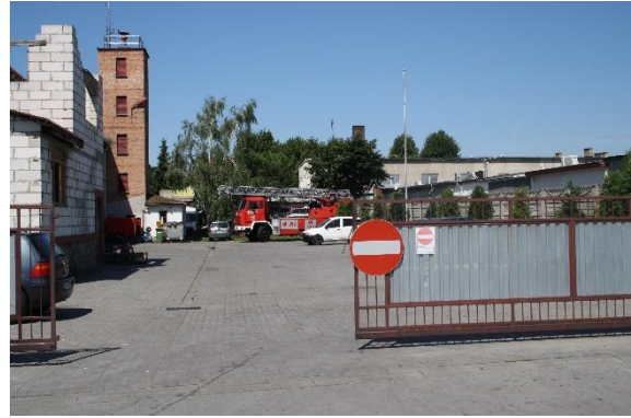
Widok na zaplecze Ochotniczej Straży Pożarnej w Sławie
